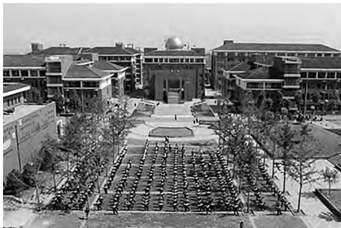
図9 淄博市高新区実験中学校校舎の様子
